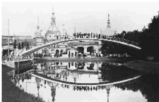
Primera construcció d'un pont de formigó armat en arc en ocasió de la fira de Bremen, Alemanya del 1890.
