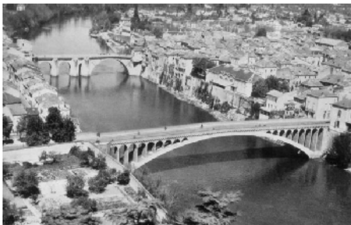
Pont de Villeneuve sur Lot. Arc de formigó en massa piconat llum de 97 m. Eugène Freyssinet (1919)
