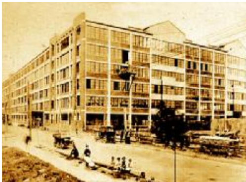
Fàbrica d'automòbils Albert Khan Ford Motor Company a Highland Park, Michigan
